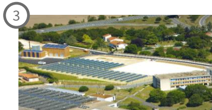
3 Réseau de chaleur de la ville de Pons (DALKIA) Pons, Charente-Maritime Capacité de 1,4 MWth Début des travaux : juin 2020
