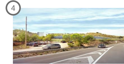
4 Réseau de chaleur de la ville de Narbonne (DALKIA) Narbonne, Aude Capacité de 2,3 MWth Début des travaux : juin 2020
