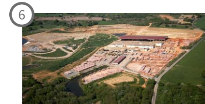
6 Site de séchage de brique en terre cuite Auvergne Région Rhône Alpes Capacité de 7,8 MWth Début des travaux : décembre 2020
