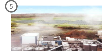
5 Site de séchage d'ingrédients laitiers Région Grand Est Capacité de 13,1 MWth Début des travaux : décembre 2020
